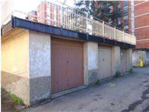
Corpo esterno delle autorimesse
