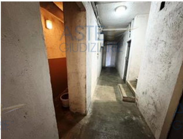
Corridoio di accesso alle cantine
