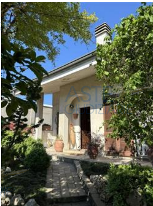
Villa bifamiliare - Edificio B
