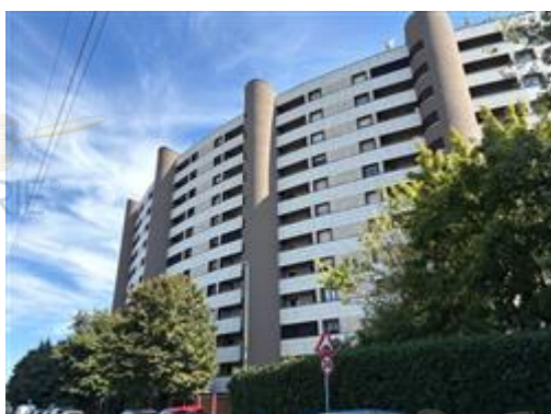
Vista del corpo A
