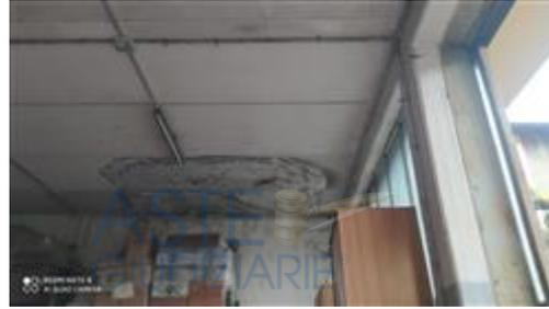
particolare delle infiltrazioni da lastrico soprastante di pertinenza
