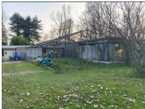
fabbricato non autorizzato
