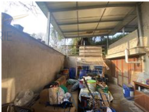
ingresso al piano interrato
