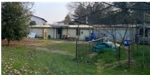
fabbricato non autorizzato
