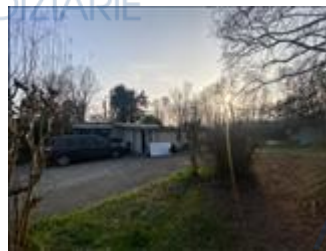
fabbricato non autorizzato
