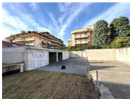
Vista del cortile e del corpo a box-autorimessa realizzato sulla particella 811
