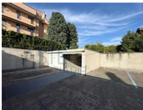
vista del corpo a due autorimesse realizzato sulla particella 812
