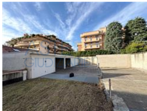
Vista del cortile e del corpo a box-autorimessa realizzato sulla particella 811
