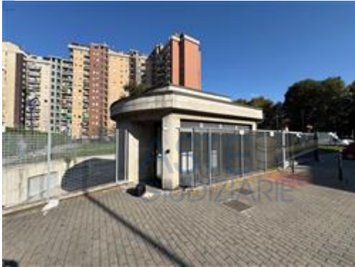
fabbricato d'accesso all'autorimessa sotterranea dotato di scale ed ascensore
