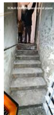
VANO SCALA CANTINE P.2° INT.
