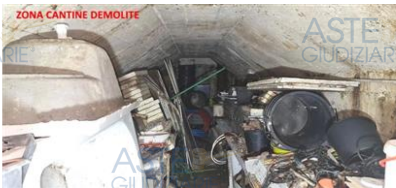
ZONA CANTINE DEMOLITE
