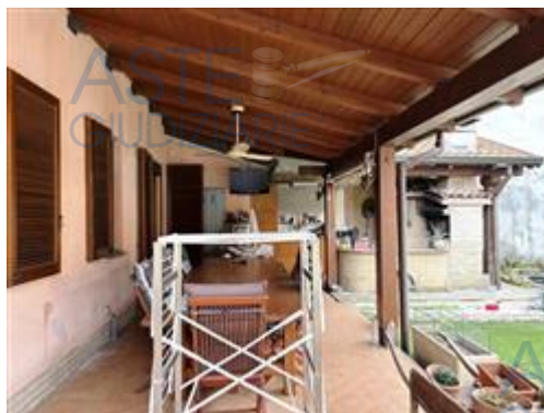
Vista del portico
