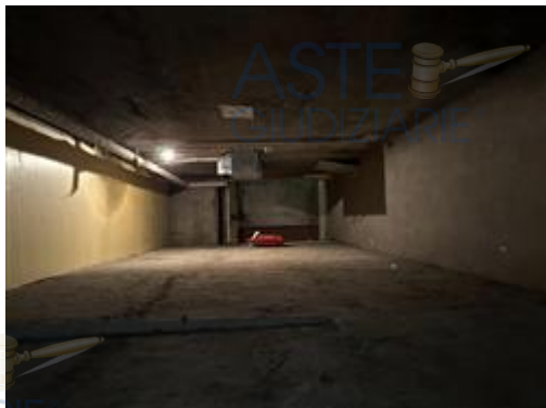
Particolare accesso al solaio
