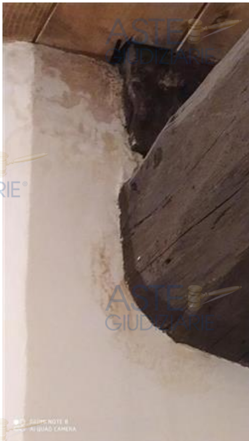
infiltrazioni da copertura
