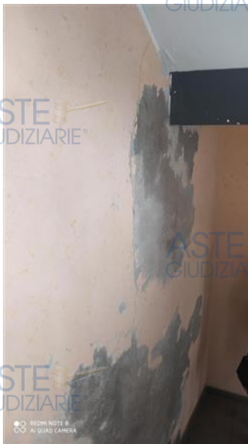
capillarità vano scale
