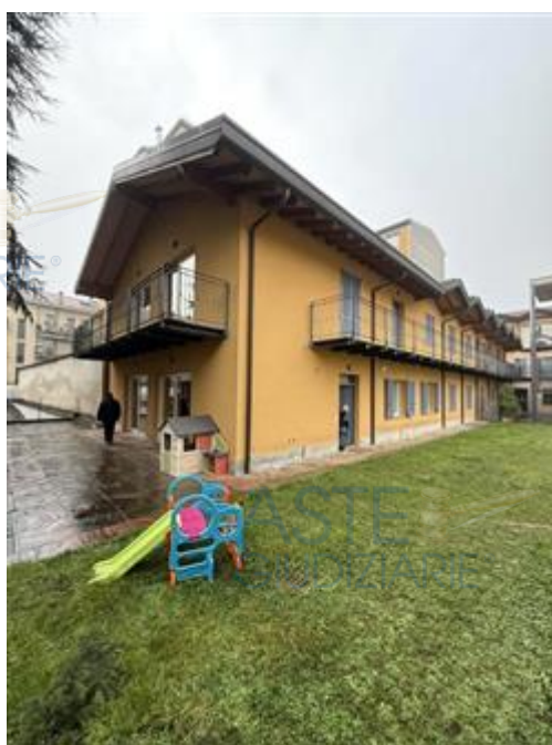
Fabbricato - corte interna
