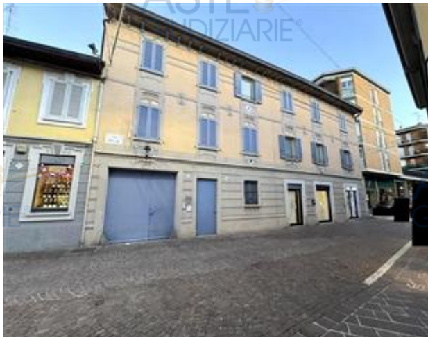
Fabbricato Prospetto Via Tre Re
