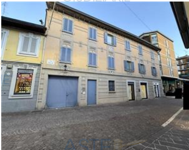
Fabbricato Prospetto Via Tre Re
