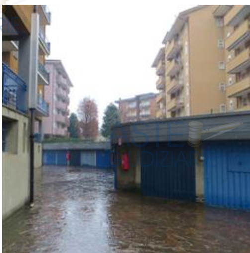
Il corsello di manovra comune
