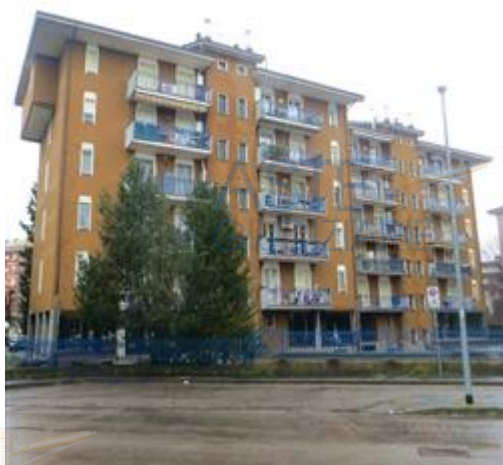
L'affaccio a Nord della palazzina
