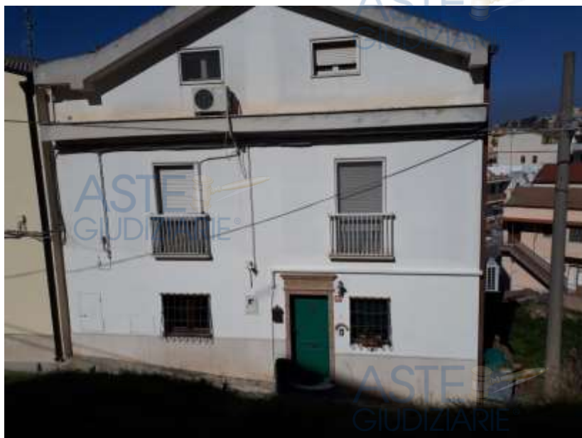
Vista da via Caduti di Kindù
