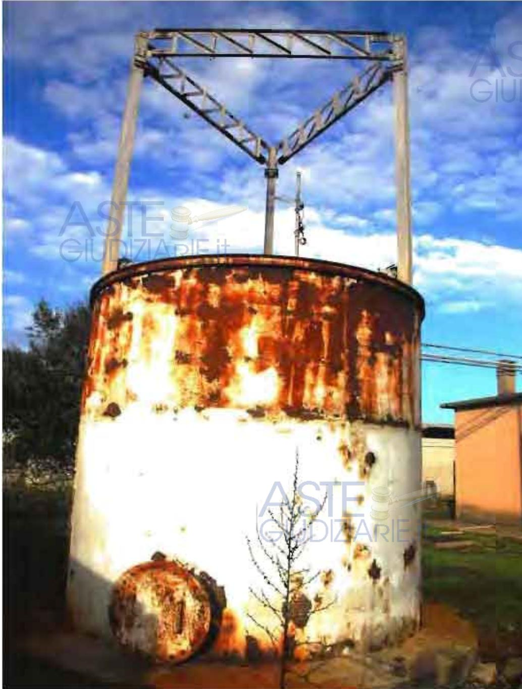
*Gasometro collegato alla Centrale Termica: appaiono evidenti i segni di decadimento*
