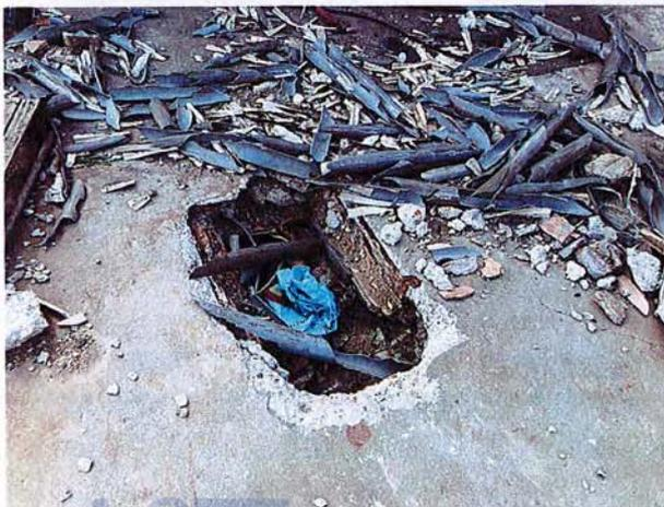
*Per effettuare il furto dei cavi elettrici, sono stati aperti tutti i pozzetti, smurati o aperti tutti i quadri e forate le pavimentazioni esterne per intercettare i cavidotti di collegamento tra gli edifici, come evidenziato dalle foto soprastanti e successive.*
