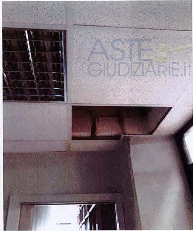
*Nell'Edificio A, nella zona degli uffici, risultano mancanti alcuni pannelli in fibra del controsoffitto. Alcuni imbarcati e caduti per una infiltrazione, altri eliminati dagli sconosciuti per avere accesso agli impianti da trafugare.*
