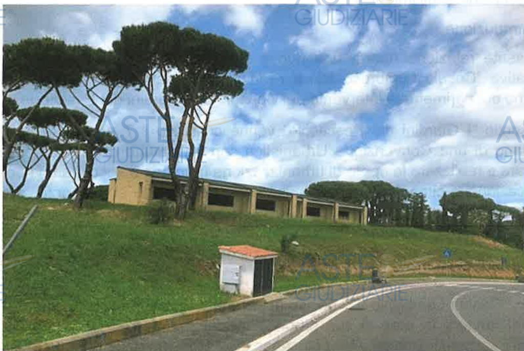
Opera di urbanizzazione secondaria a scomuto, quasi completata ma bloccata dalla indecisione degli EE.LL.: (prima Scuola ora forse Caserma dei Carabinieri.)
