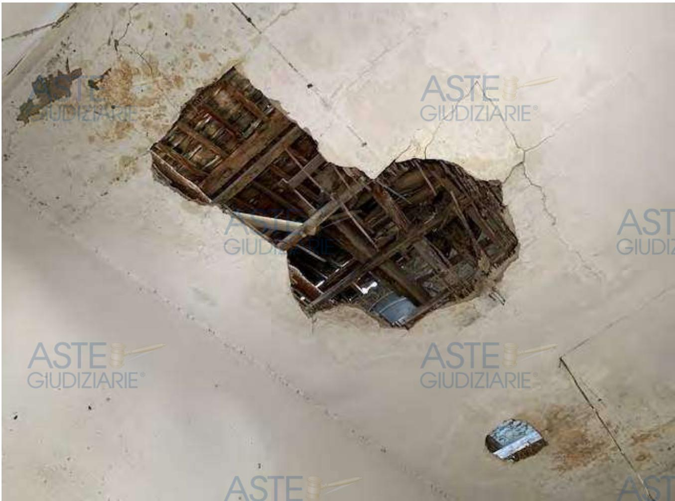
FOTO n° 19 - LA FOTO MOSTRA IL CROLLO DEL SOFFITTO DI UNA STANZA CON CONSEGUENTE INFILTRAZIONE DI ACQUE PIOVANE
