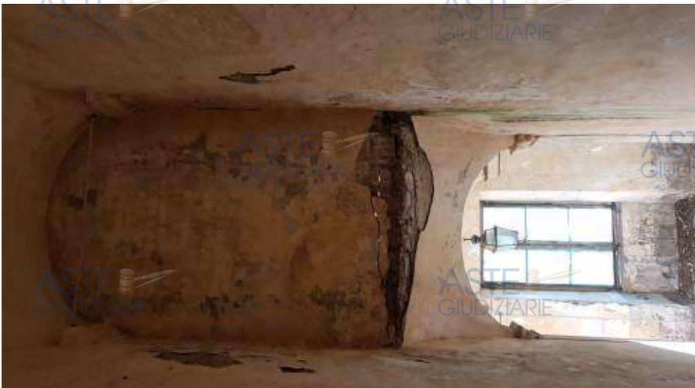
FOTO n° 11 - LA FOTO MOSTRA LO STATO DI AVANZATO DEGRADO DI UNO DEI VOLTINI DELLE SCALE PRINCIPALI
