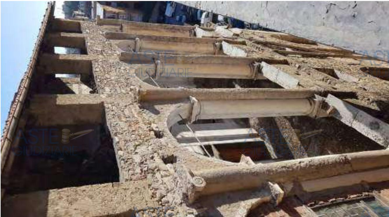
FOTO n° 9 - PARTICOLARE DELLA FACCIATA OVEST DEL PALAZZO E DEL DEGRADO CON EVIDENTI DISTACCHI DI INTONACI
