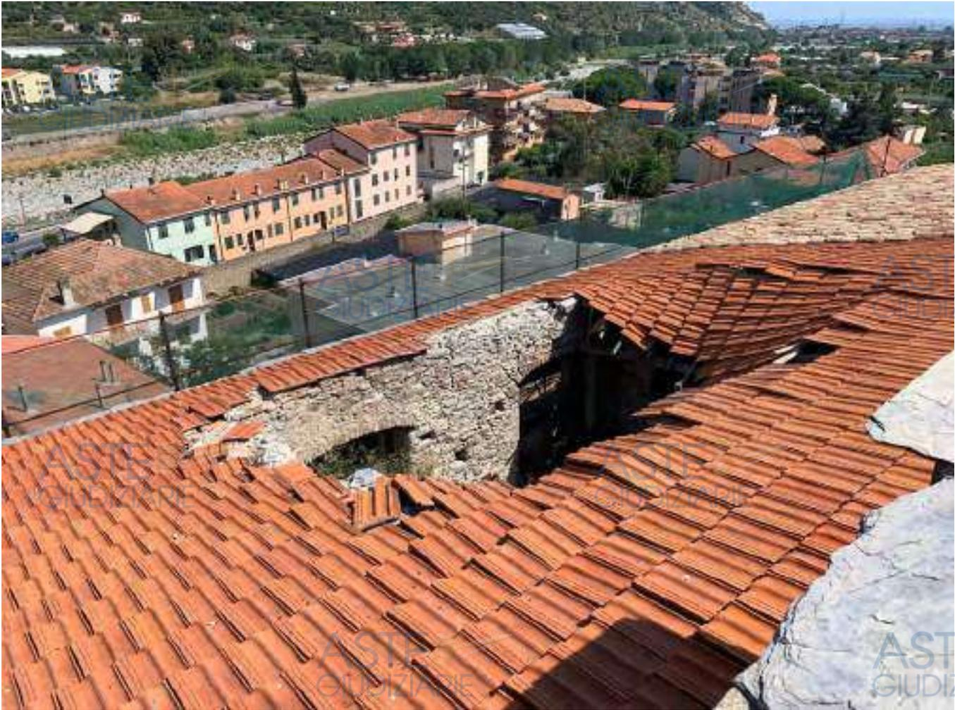
FOTO n° 12 - LA FOTO MOSTRA IL CROLLO DI PARTE DEL TETTO ,
