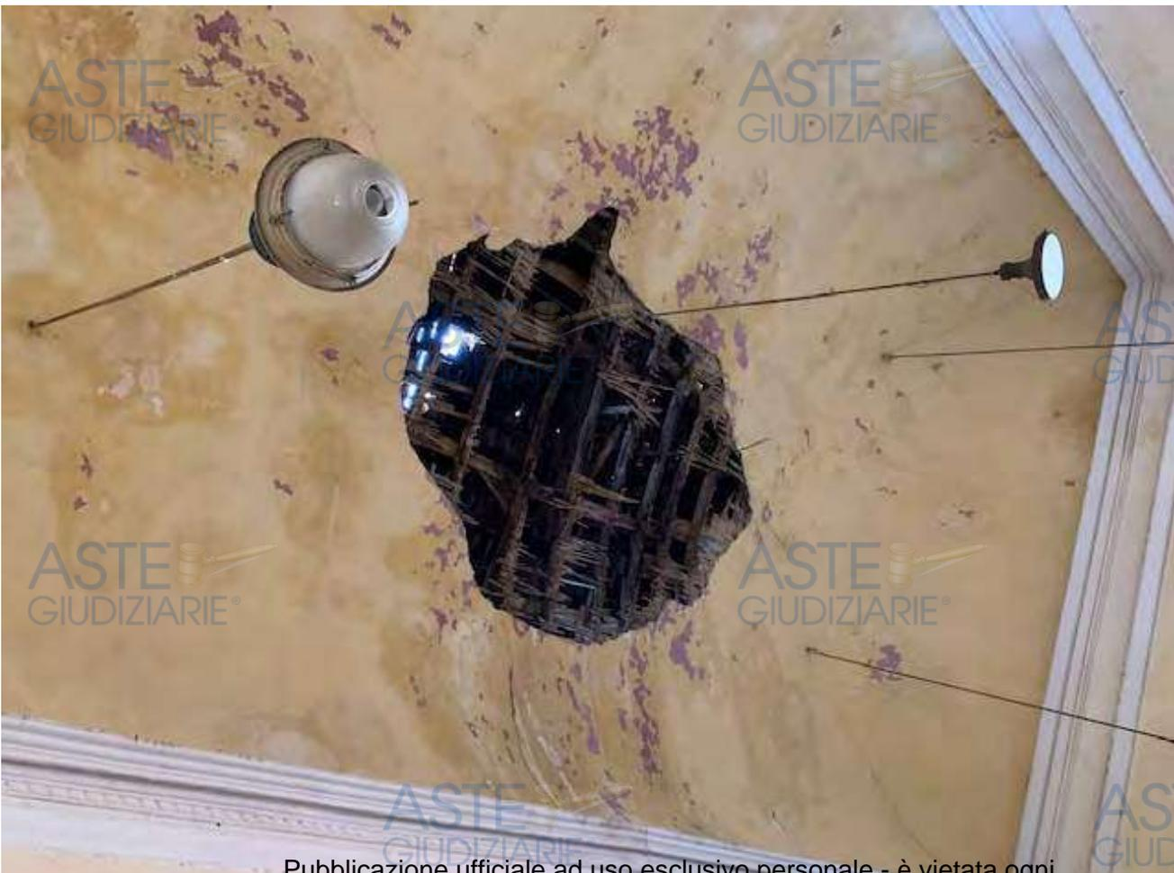
FOTO n° 17 - LA FOTO MOSRA IL CROLLO DI PARTE DEL SOFFITTO A VOLTA DEL SOLONE PRINCIPALE AL PIANO AMMEZZATO CON CONSEGUENTI COIPOSE INFILTRAZIONI DI ACQUE METEO
