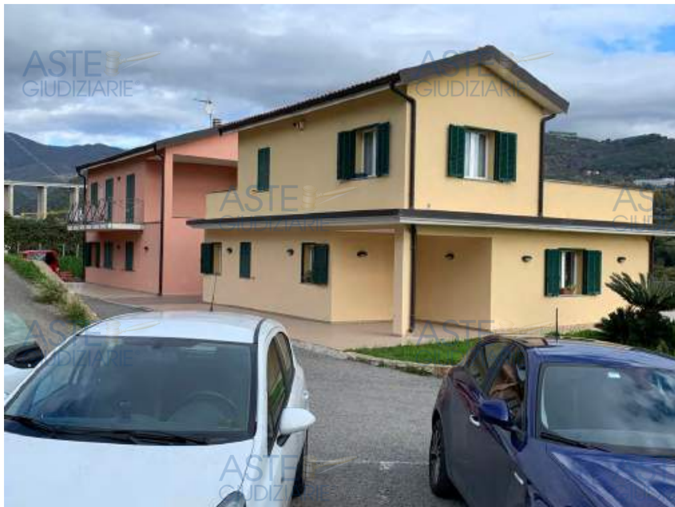
FOTO n° 2 - LA FOTO MOSTRA IL PROSPETTO OVEST DEL FABBRICATO DI VALLE ARMEA
