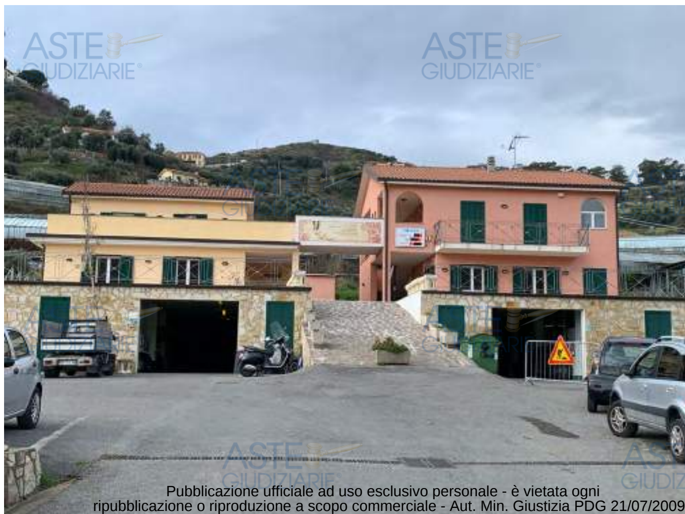
FOTO n° 3 - LA FOTO MOSTRA IL PROSPETTO EST DEL FABBRICATO DI VALLE ARMEA
