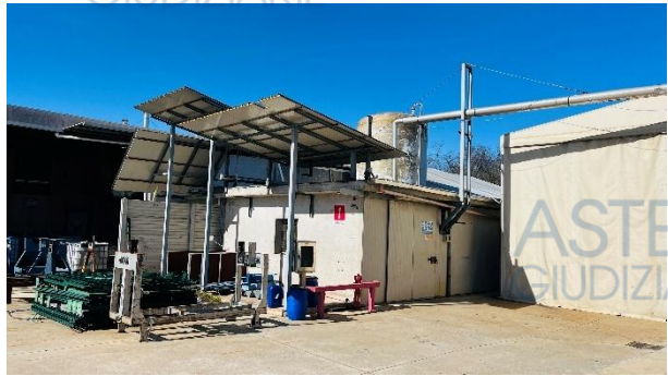
Edificio B – Autorimessa / officina
