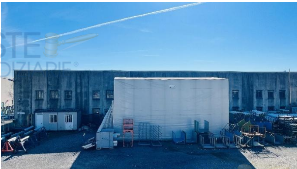
Edificio C – Magazzino tessuti
