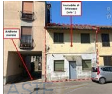
Prospetto su Via Pasubio ed androne carraio da cui si accede al cortile comune e al deposito (Lotto B)
