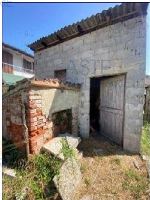
Piccolo deposito (h 1,50 m.)
