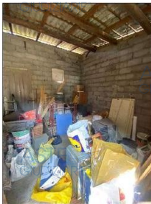
Vista interna dalla porta d'ingresso
