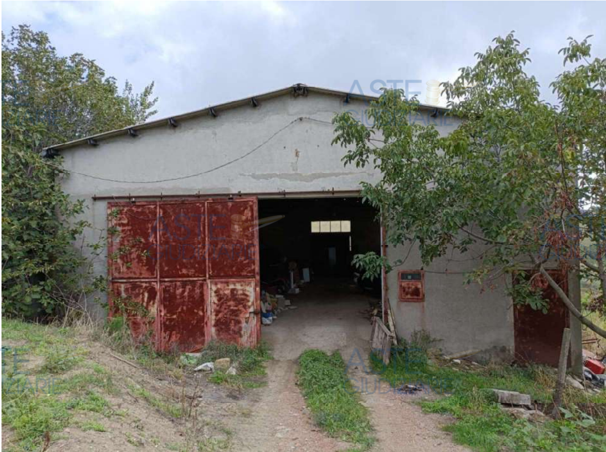
Figura 3 – Panoramica Capannone in C.da Macchia, Ripacandida (PZ).
