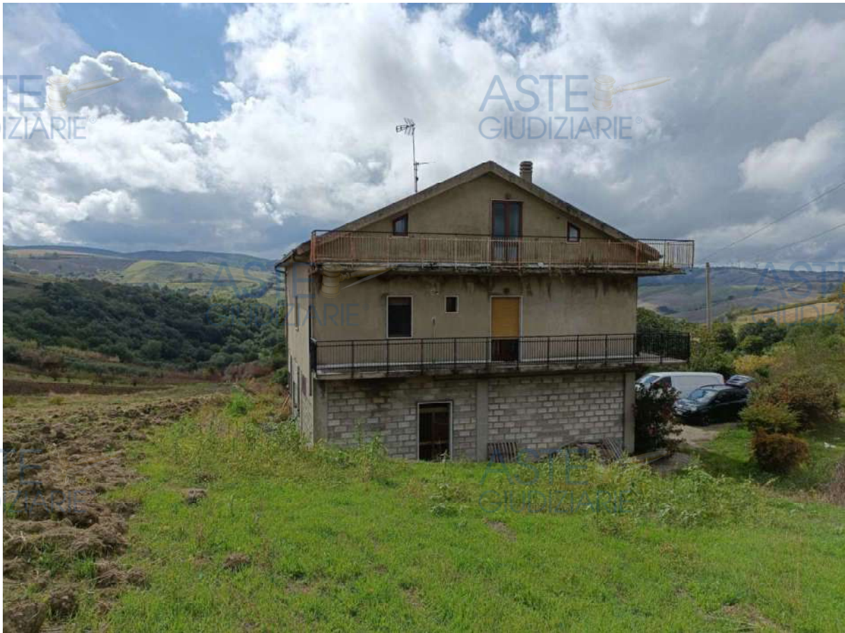
Figura 2 – Panoramica Abitazione in C.da Macchia, Ripacandida (PZ).
