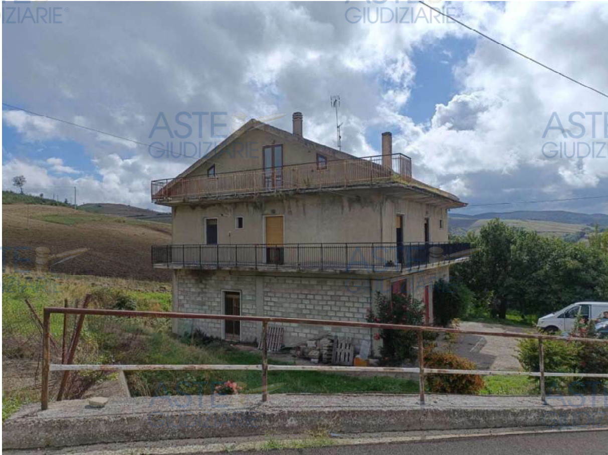
Figura 1 – Panoramica Abitazione in C.da Macchia, Ripacandida (PZ).
