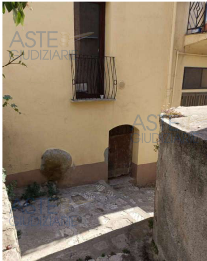
Figura 7 – Panoramica Ingresso Deposito, Via Michele Placido, Ripacandida (PZ).
