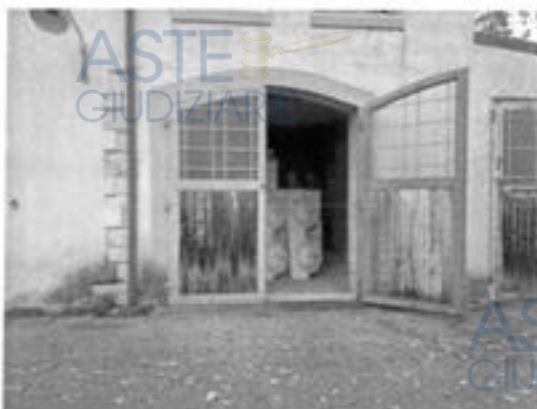
Deposito al piano terra
