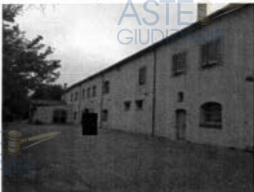
Vista fabbricato su part. 138
