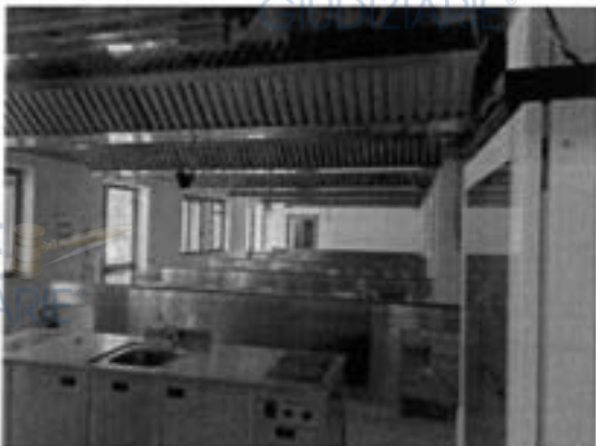
Vista fabbricato su part. 160
