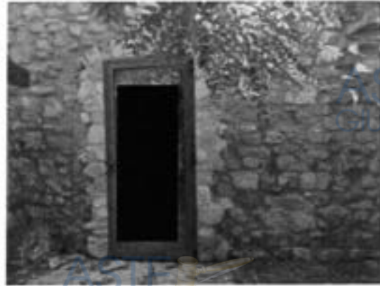
Vista fabbricato su part. 161
