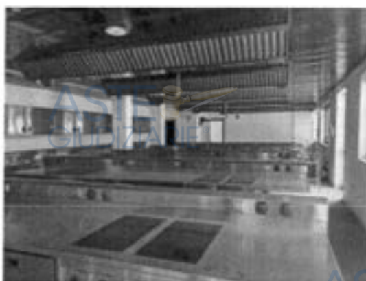
Vista fabbricato su part. 160
