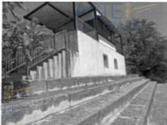
Vista fabbricato su part. 169
