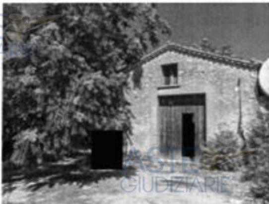
Vista fabbricato su part. 158
