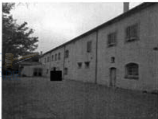
Vista fabbricato su part. 138
