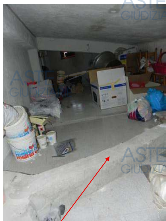
condotta a servizio dell'appartamento di proprietà di terzi
