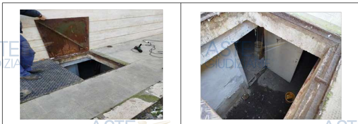
Figura 1. botola utilizzata per accedere all'unità immobiliare
