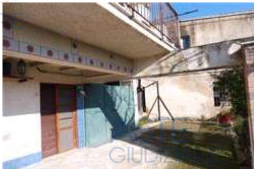
Esterno facciata Sud - piano S1
