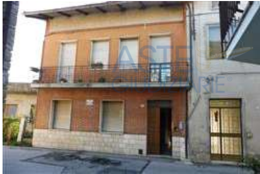
Esterno facciata Nord
