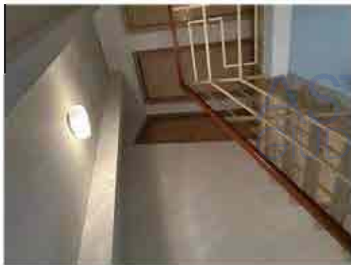
foto accesso porta soffitta (prima a sinistra)
