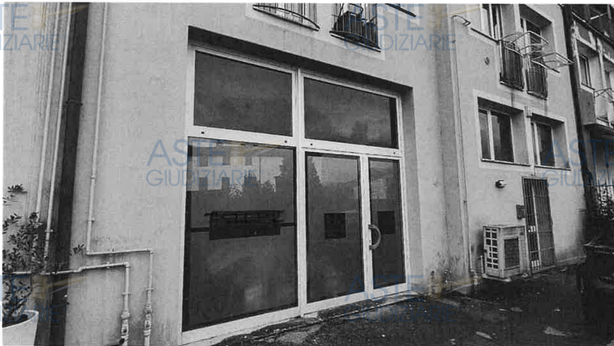
Vista prospetto immobile in oggetto
