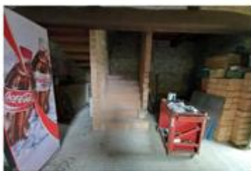
FOTO N°3: scale collegamento tra piano terra e piano primo
