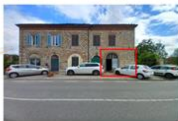
FOTO N°8: prospetto sud, fronte principale
