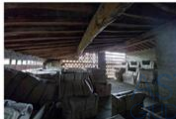
FOTO N°8: veduta d'insieme del piano secondo
