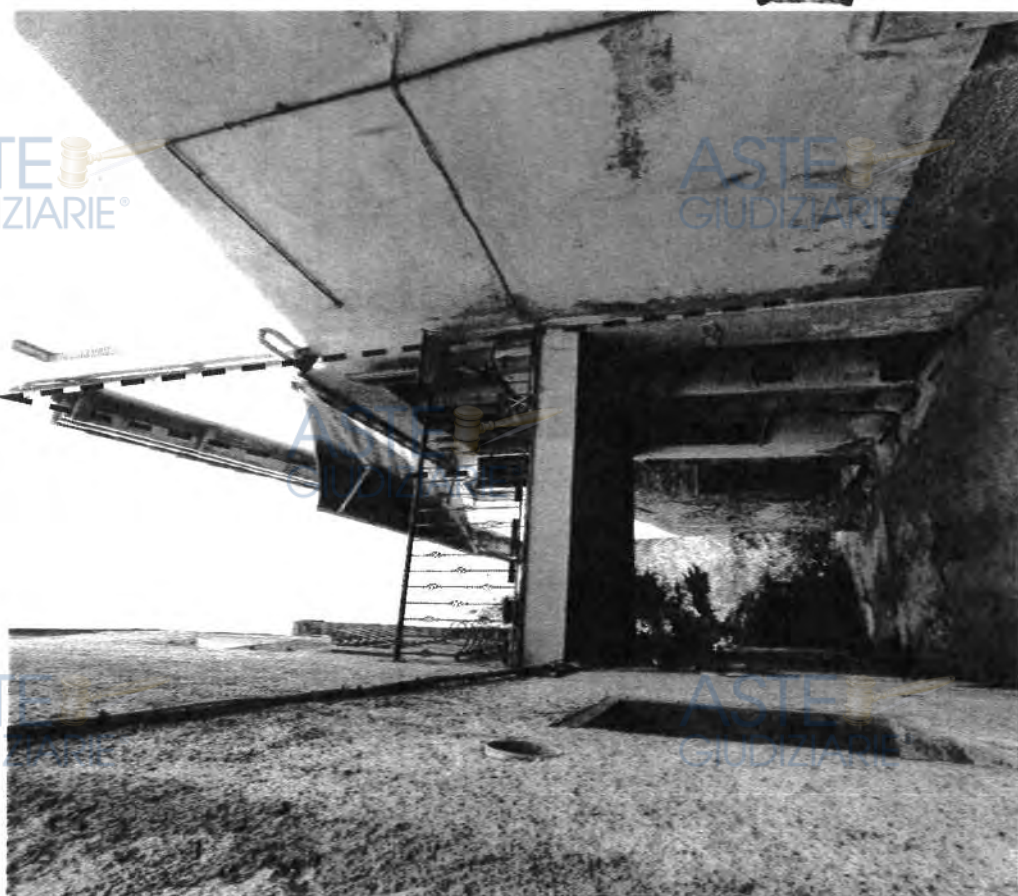
- FOTO 1 - Vista da via Sandro Pertini
