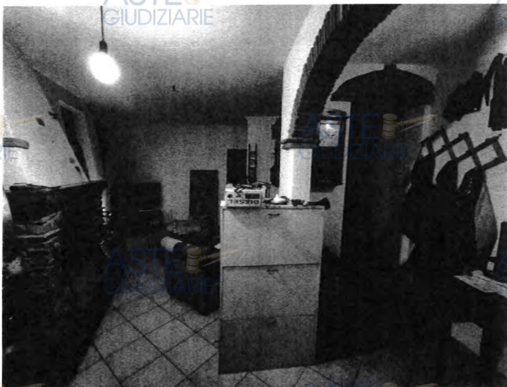
- FOTO 4 - Soggiorno/ingresso/vano scale p.t.
