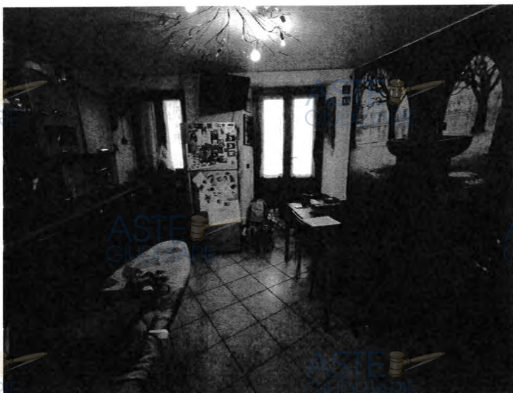
- FOTO 8 - Vano al 1°p. attualmente adibito a cucina privo dei requisiti igienico-sanitari
