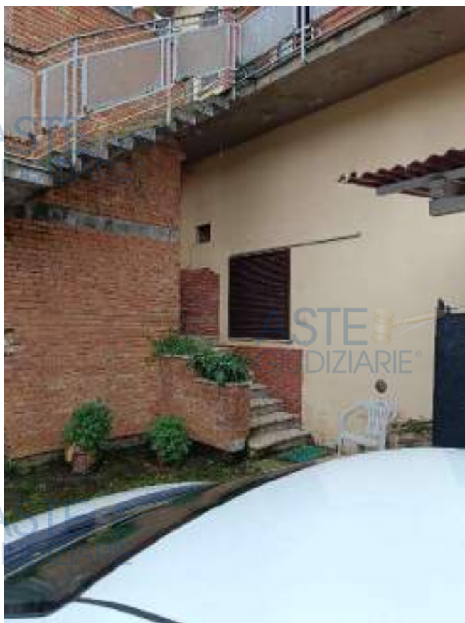
FOTO 5: scale esterne di accesso all'abitazione
