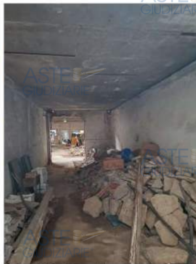
FOTO 4: vista interna del capannone artigianale
