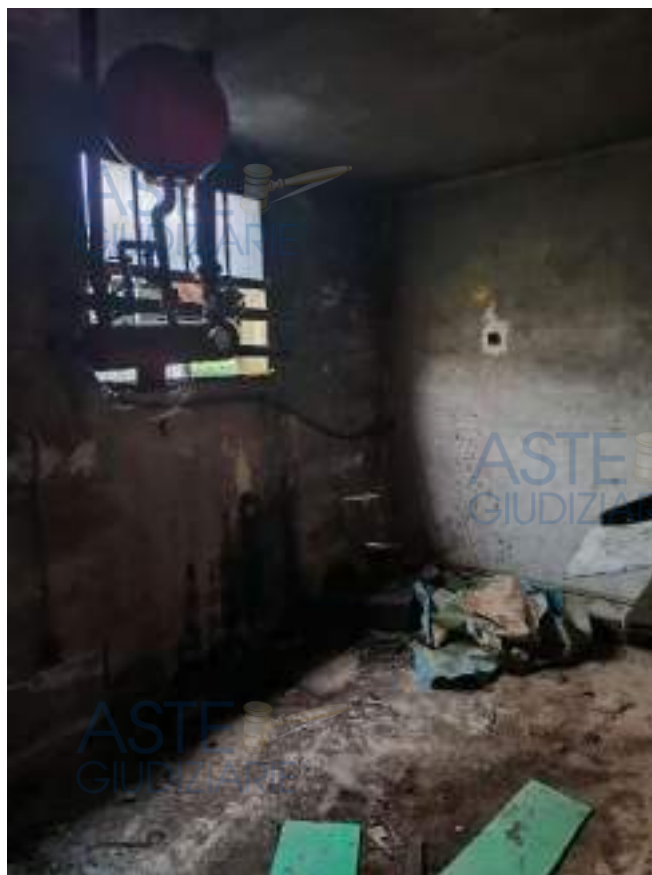
FOTO 6: vista interna del capannone artigianale
