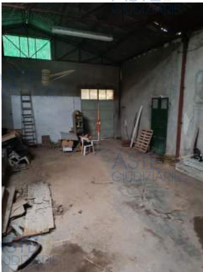
FOTO 7: vista interna del capannone artigianale
