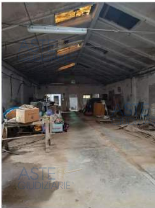
FOTO 2: vista interna del capannone artigianale
