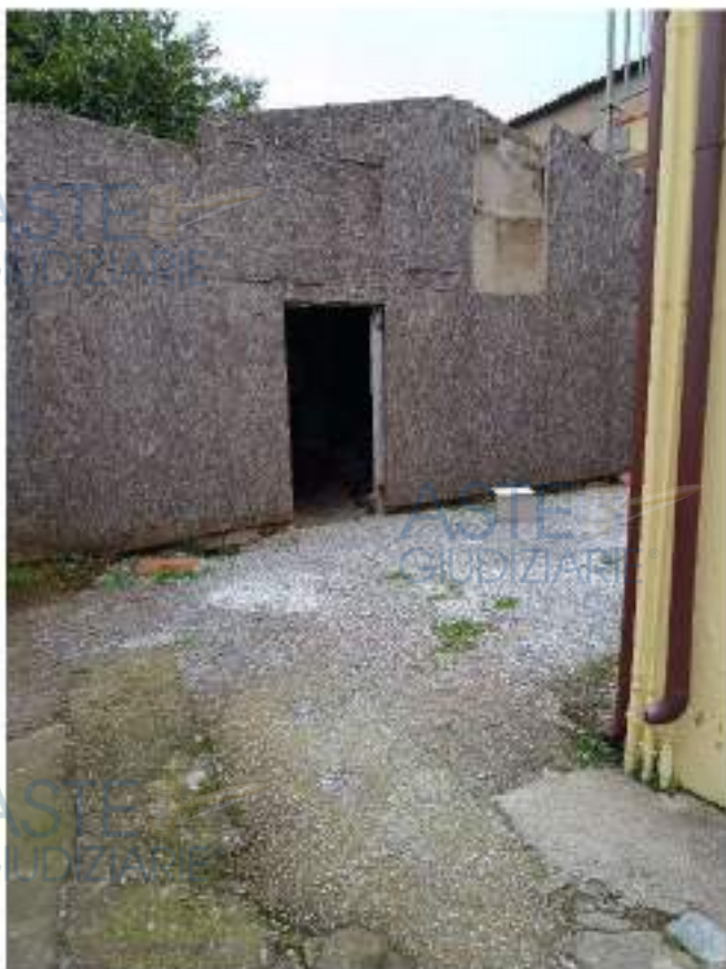
FOTO 1: vista dell'ingresso sul lato nord e della corte a comune (mapp. 333 sub 1)
