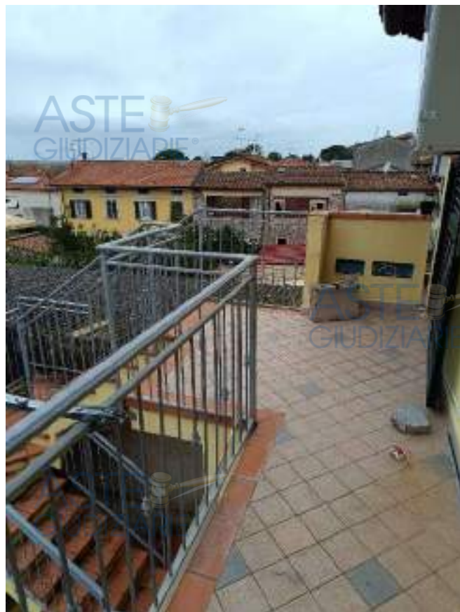
FOTO 4: vista del balcone esterno con l'unità immobiliare part. 332 sub 11
