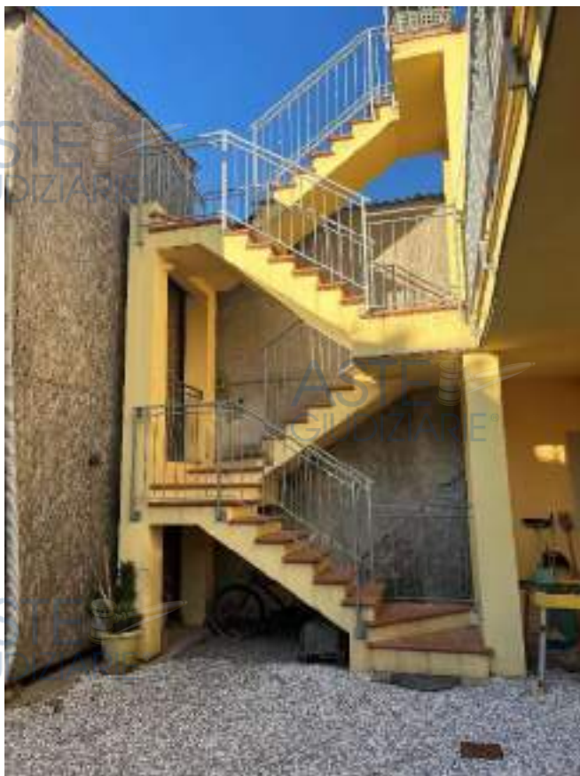
FOTO 3: vista delle scale esterne a comune di accesso ai piani primo e secondo del fabbricato
