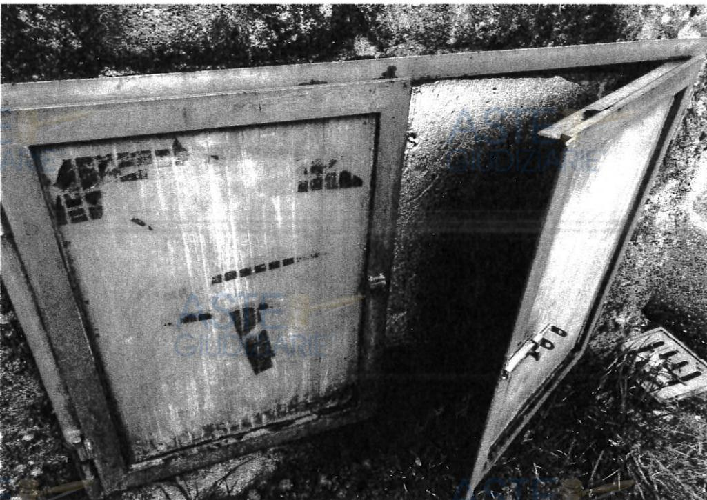
Foto 28 – vano dei contatori dell'acquedotto posto all'esterno nel muro di confine sul lato destro dell'ingresso dal parcheggio pubblico a confine con la pubblica via
