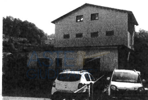
veduta del fabbricato mappale 295
