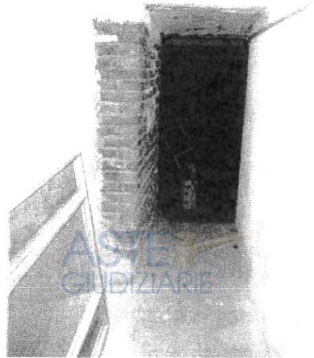
veduta della nuova apertura nella muratura portante del fabbricato ripresa dal corridoio vano 8.4: oltre l'apertura si trova la cantina - magazzino vano 8.5
