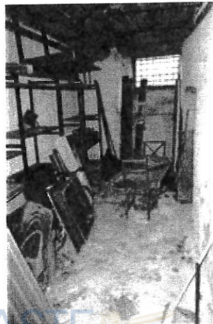
veduta della cantina - magazzino che confina con vicolo delle Mura
