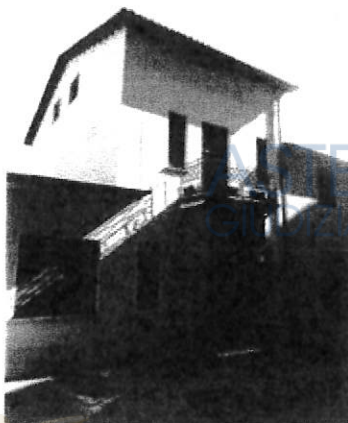
veduta del fabbricato mappale 295 oggetto di stima ripresa da vicolo delle Mura
