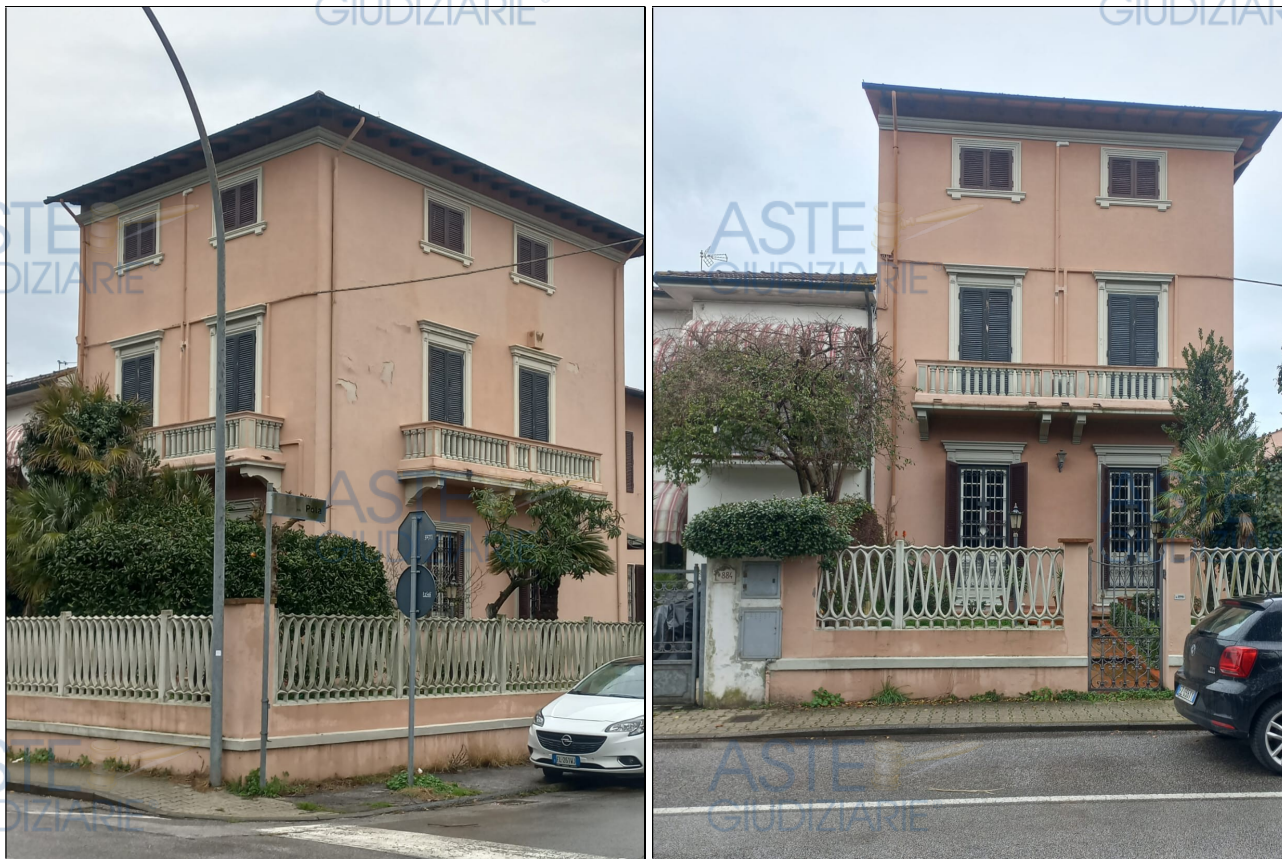
Viste esterne del corpo principale dell'abitazione da Angolo Via Fratti-Via Pola e ingresso da Via Fratti.
