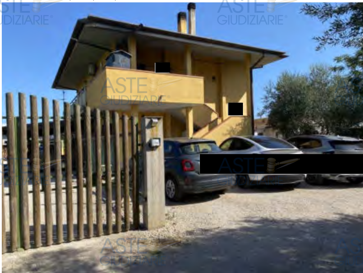
Foto n. 11 - Prospetto principale casa colonica
