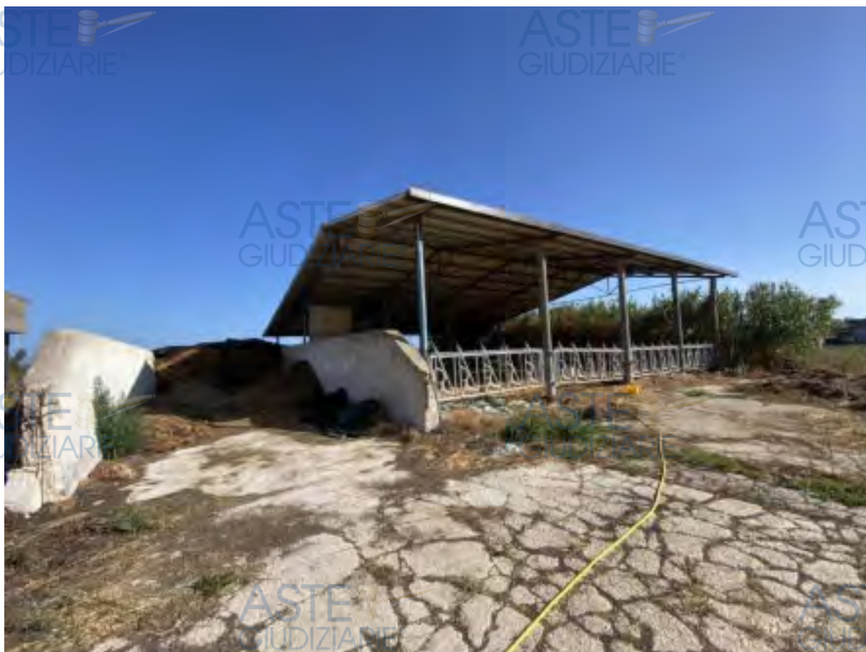
Foto n. 15 - Fienile e silos vista esterna
