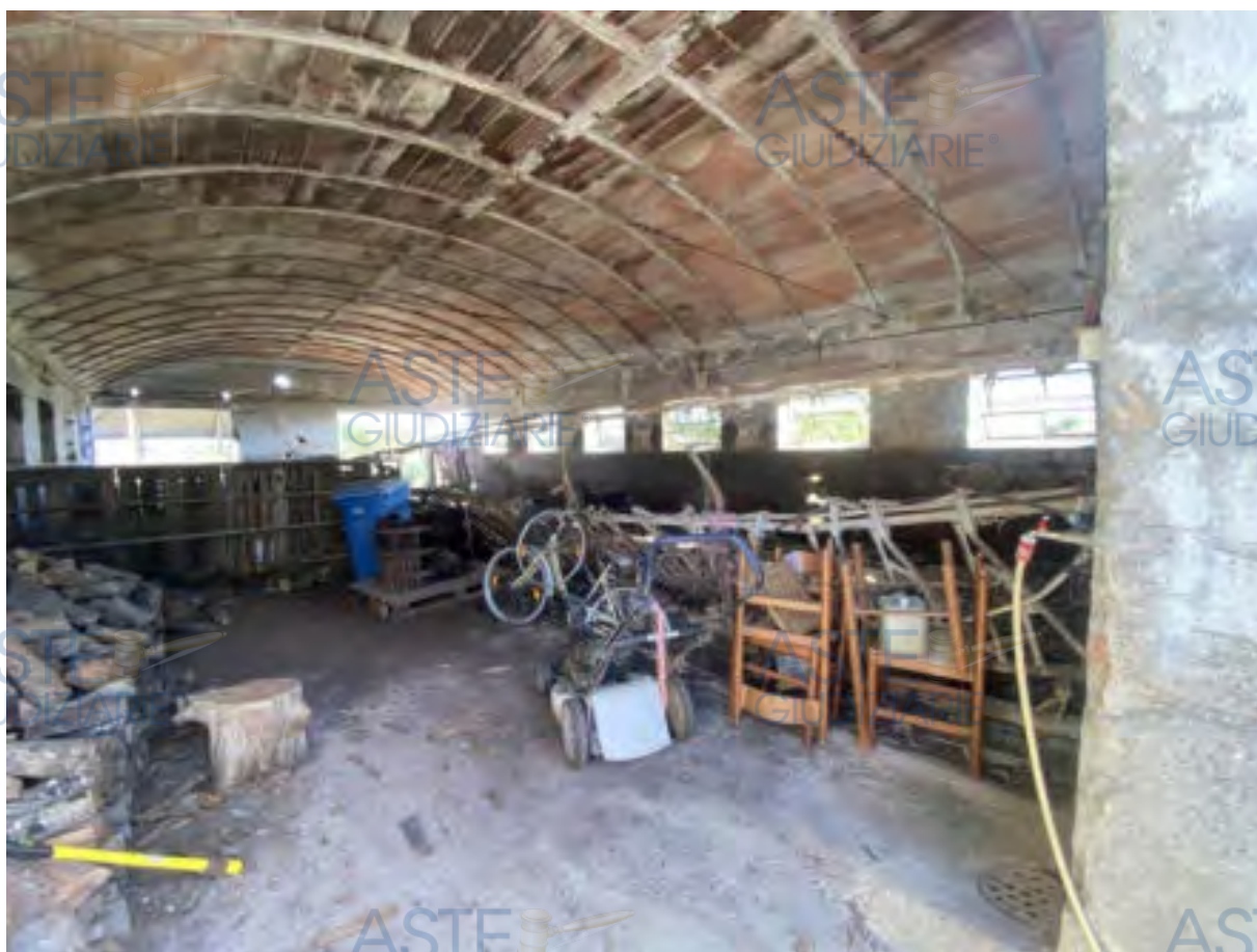
Foto n. 14 - Stalla vista interna
