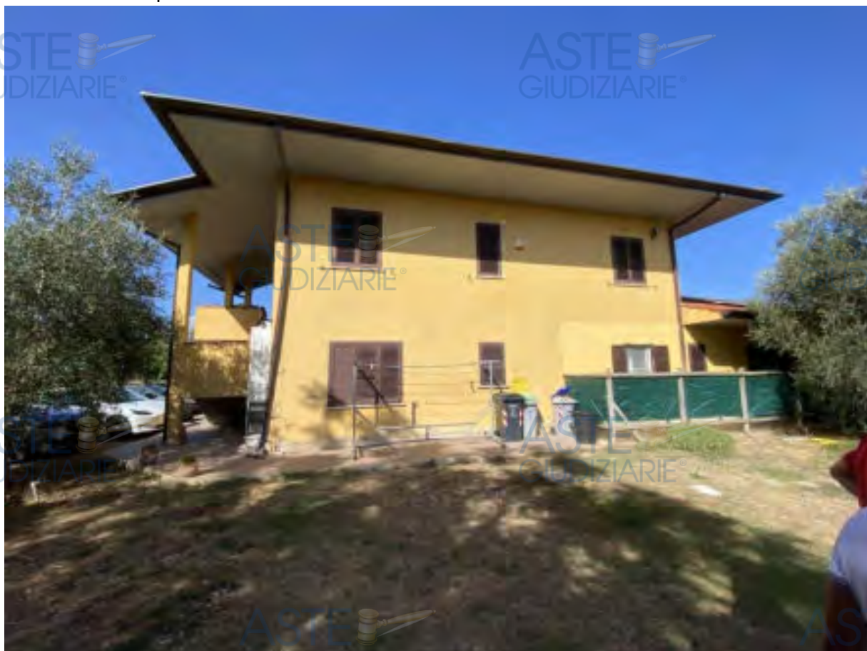
Foto n. 12 - Prospetto laterale casa colonica
