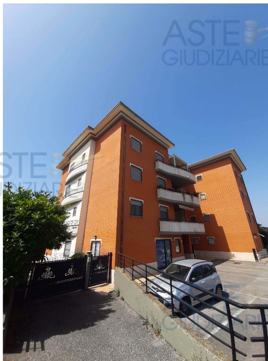
VISTA DEL FABBRICATO IN CUI RICADE L'IMMOBILE OGGETTO DI PIGNORAMENTO Via Lelia Caetani n. 2 – Sermoneta (LT) Foglio 38 – Particella 1340 - subalterno 1
