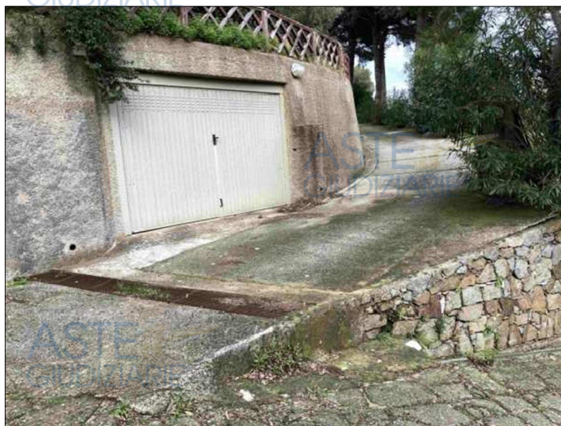
Ingresso autorimessa e viabilità gravata da diritto di passo
