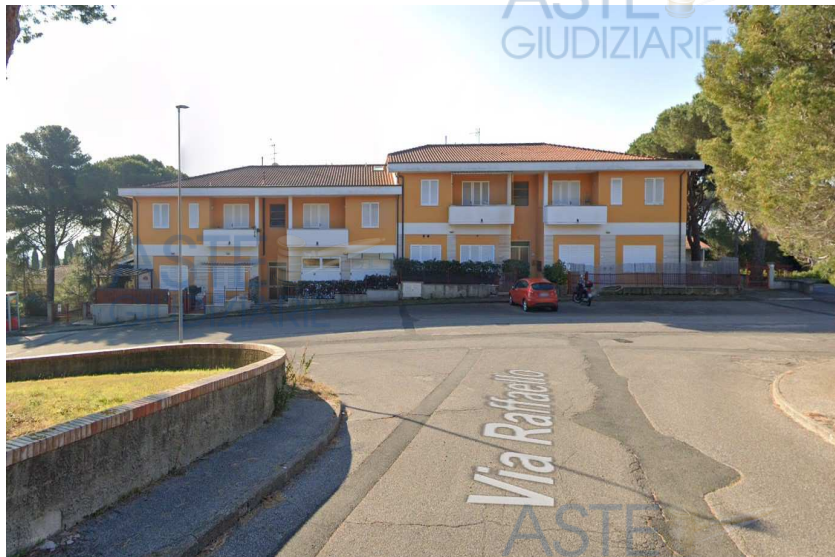
Fronte principale dell'edificio su Via Raffaello
