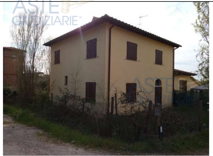
Vista fabbricato – giardino retrostante
