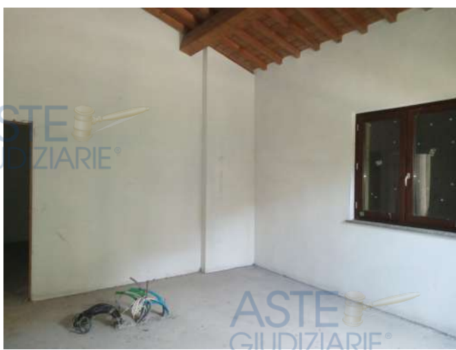
Piano primo – camera con pareti da realizzare
