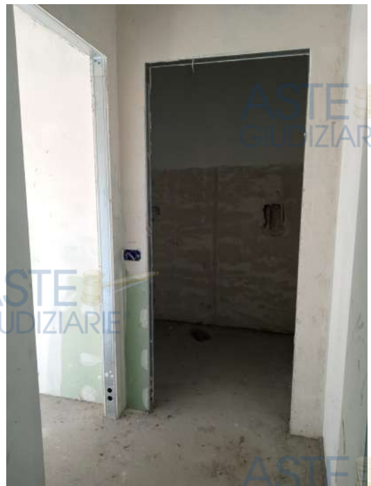
Piano primo- accesso bagno
