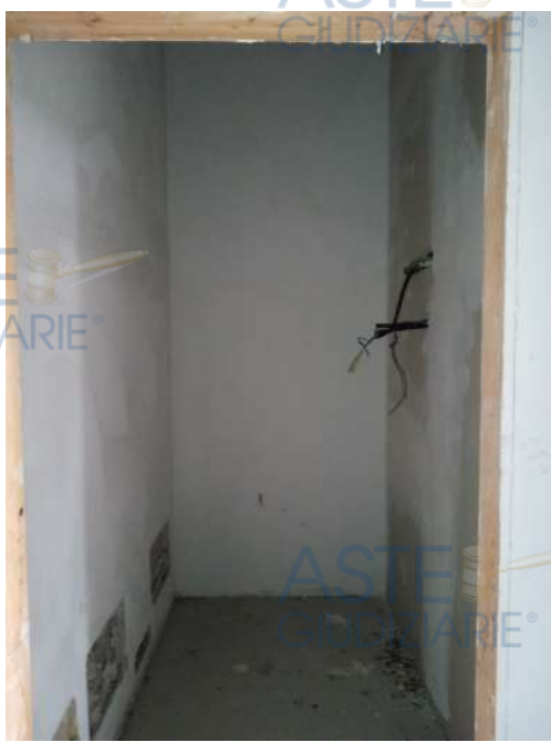
Spazi interni – bagno
