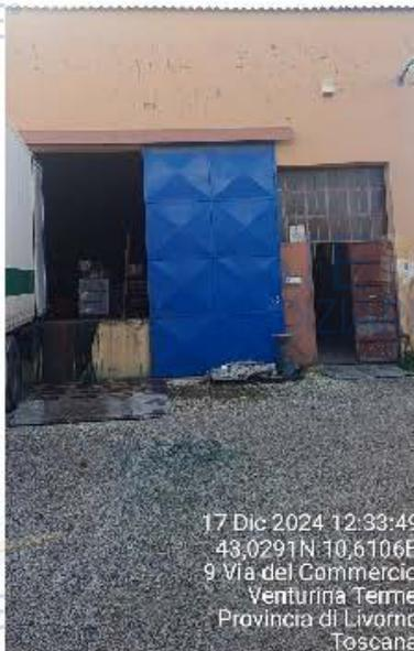
Dalle risultanze del sopralluogo si considera lo stato manutentivo del capannone/magazzino e quello della zona uffici mediocre con necessità di intervento manutentivo.
