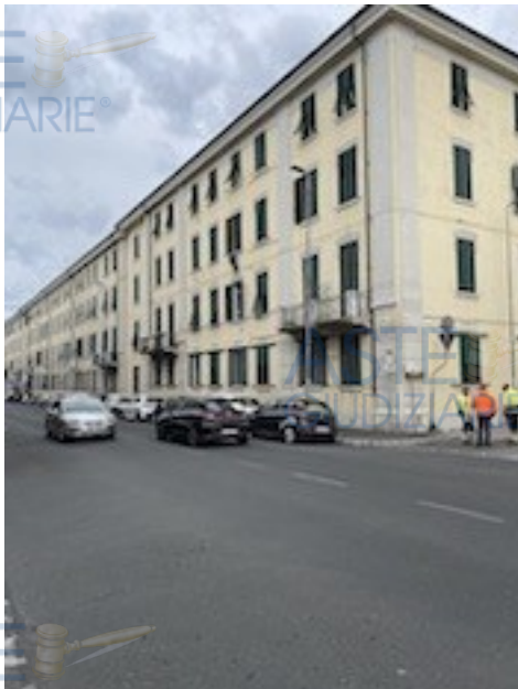
Fot. 1 – Vista da V.le Risorgimento
