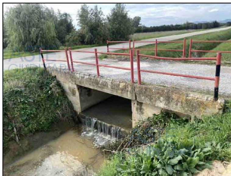
Foto 2 – Sezione canale fronte sud p.lle 69 e 102 Foto in corrispondenza della strada di accesso al terreno
