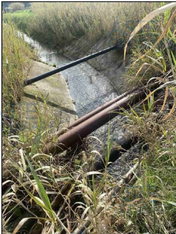
Foto 5 – Attraversamento tubazioni del ‘Fosso Valnera’
