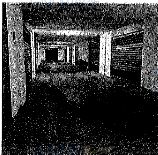
Vista anello di distruzione ai vari box auto piano interrato
