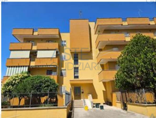
Prospetto condominiale su piazza pellizzari
