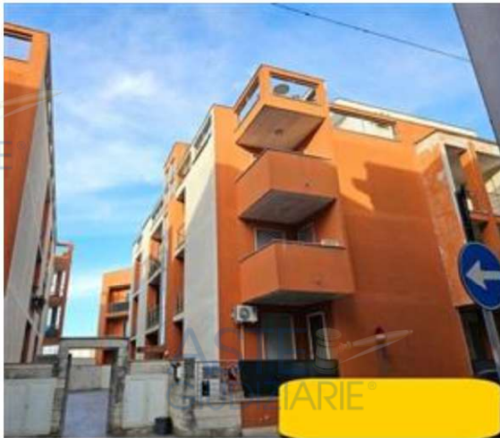
Prospetto fabbricato condominiale su via marconi
