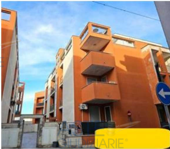
Prospetto fabbricato condominiale su via marconi
